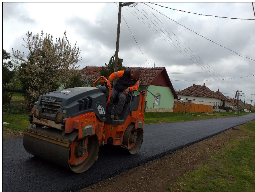
DEÁK FERENC UTCA ASZFALT ÚT HENGEREZÉSE
